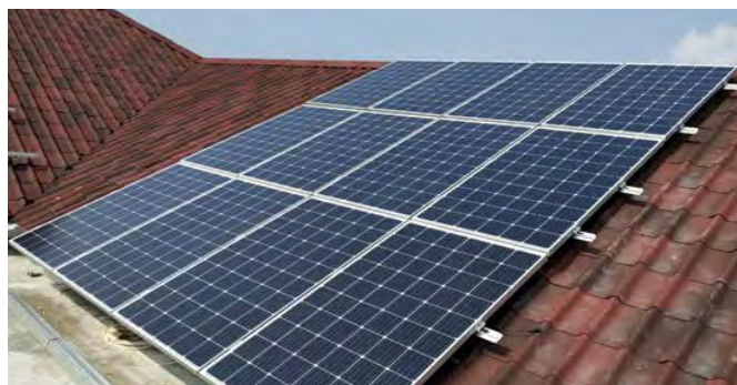
Gambar 2.5 Pemasangan Solar Panel Frame di atap SMP Negeri 203 Jakarta Picture 2.4 Installation Frame Solar Panel on the roof SMP Negeri 203 Jakarta
